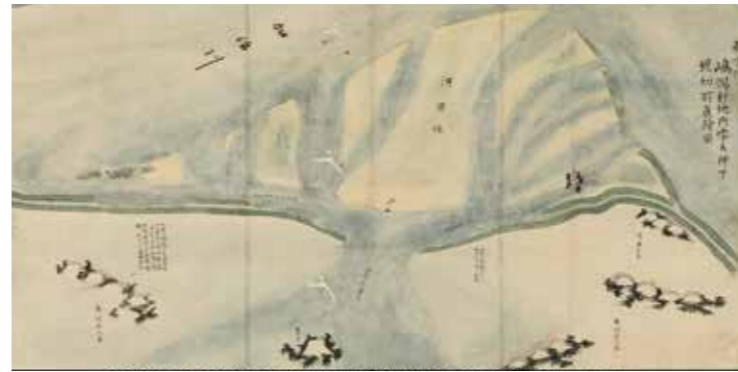
図10 加治川の堤防決壊の図「安政四年島瀉破堤真景」
